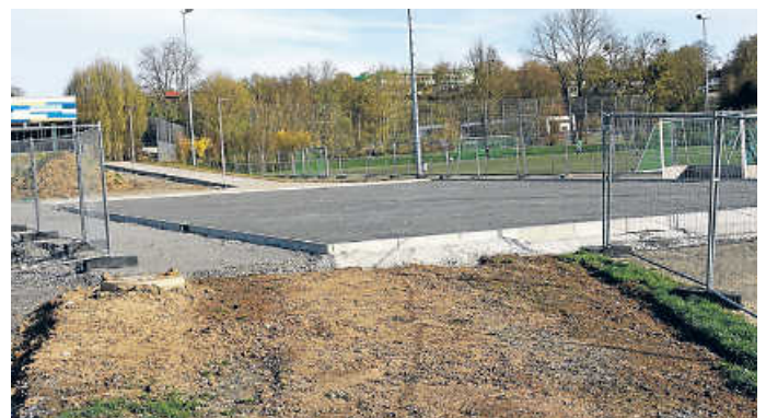
Die neue Grundfläche des Kleinspielfeldes hinter der Feuerwehr ist bereits gut zu sehen Foto: Stadt Öhringen
