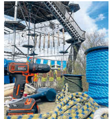
Instandsetzungsarbeiten in Vorbereitung der Saison 2023
