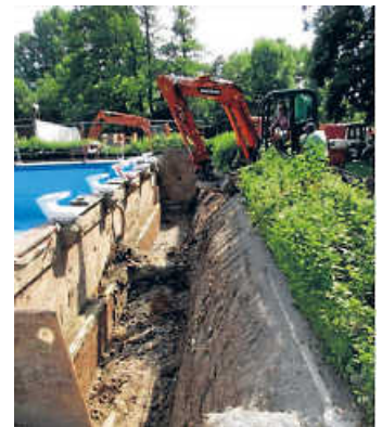
Bereits 2019 wurden Rohre um das Becken in Michelbach saniert
